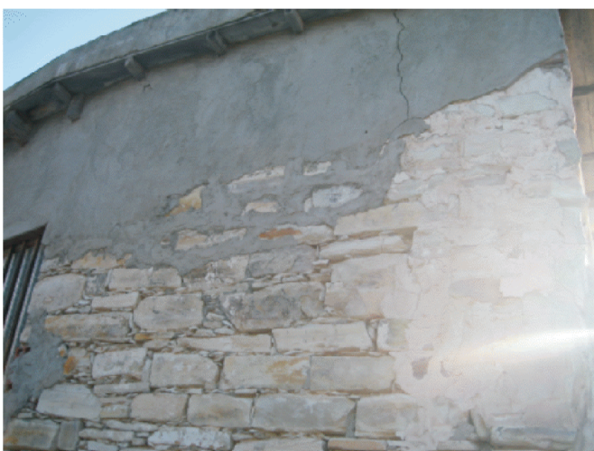
επίχρισμα πέτρινης τοιχοποιίας από τσιμεντοκονίαμα
