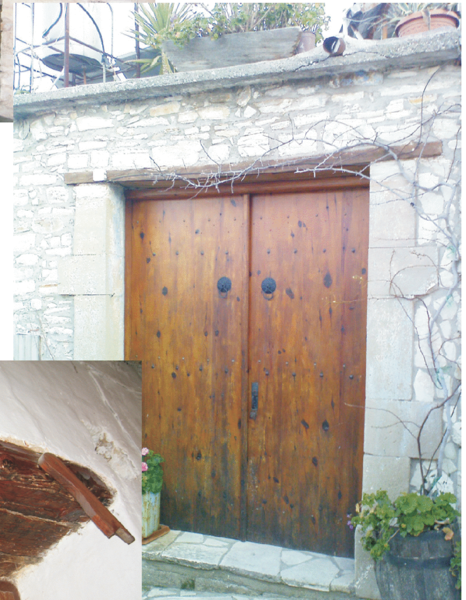
κατασκευή ανωφλιών
