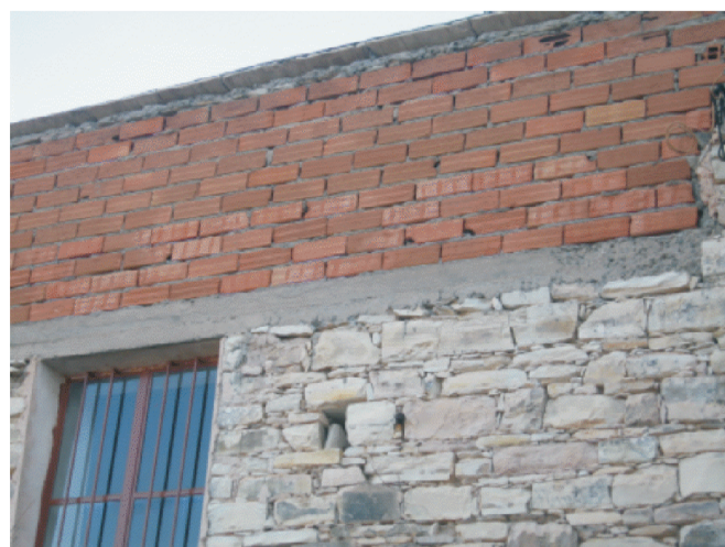
αντικατάσταση πλινθариού από μπετόν και τούβλο
