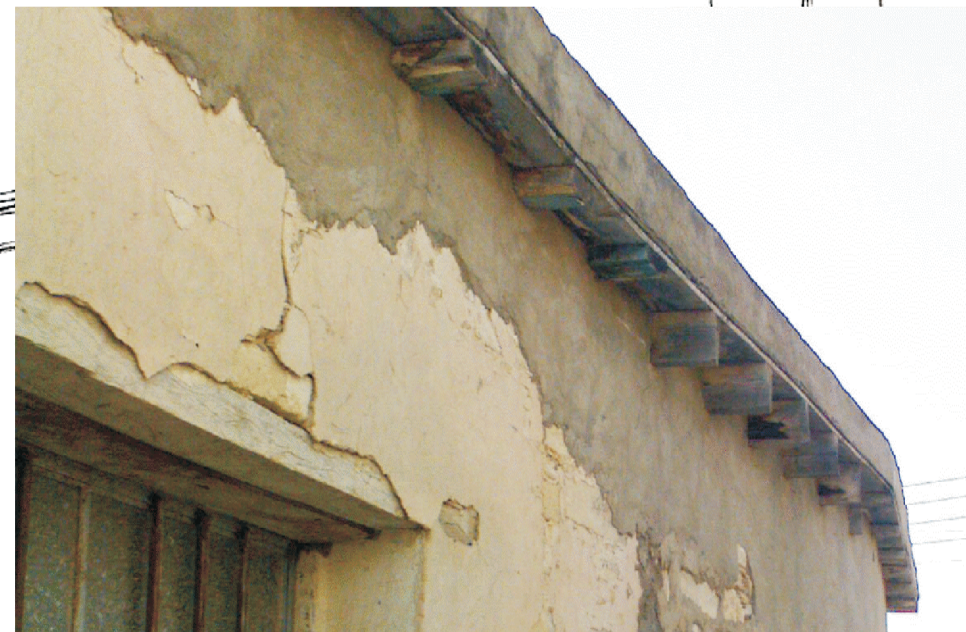
κρόδωμα κατασκευασμένο με προεξοχή των βολιτζιών από τη τοιχοποιία (με μεταγενέστερες επεμβάσεις)
