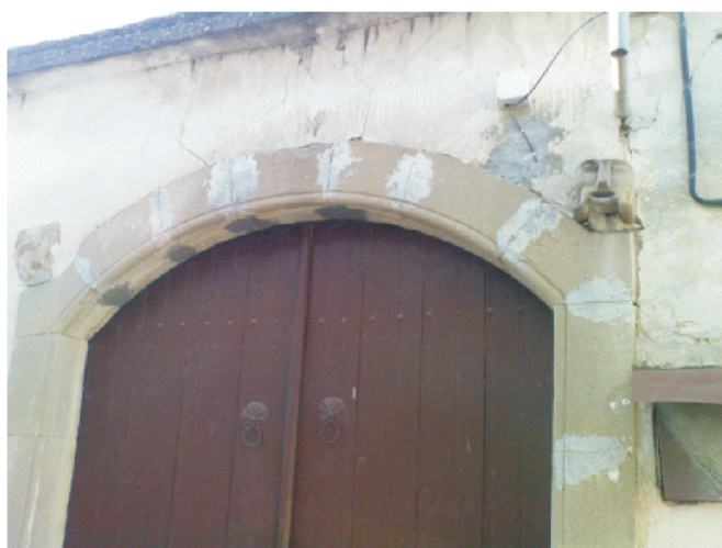
αρμολόγημα από ασβεστοκονίαμα
